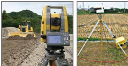
GNSS 固定局/無線送信機
