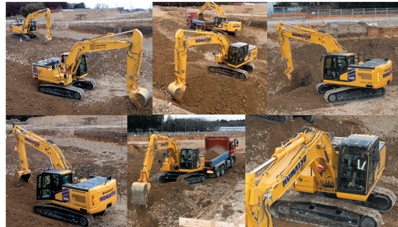
陰山建設は自社で導入間もないコマツの最新鋭ICT建機「PC200i-12」を栃木県那須塩原市内の土木工事の現場で用いる。現場では掘削した土砂をダンプトラックで場外に搬出する作業を実施していた。掘削後の法面部分はPC200i-12に標準装備するマシンコントロールを用いて設計通りに仕上げる。代表取締役の陰山正弘氏は「コマツの伴走なしには、ここまでの取り組みは不可能。今後もっと感謝することになるはず」と将来を見据える。
