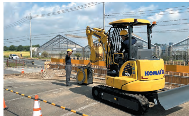
人々の生活圏に近い現場で稼働する電動建機
