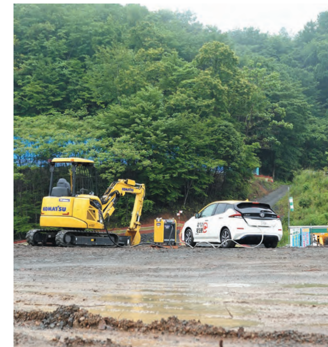
山間部の現場で電動建機に給電するMESTA Gen
