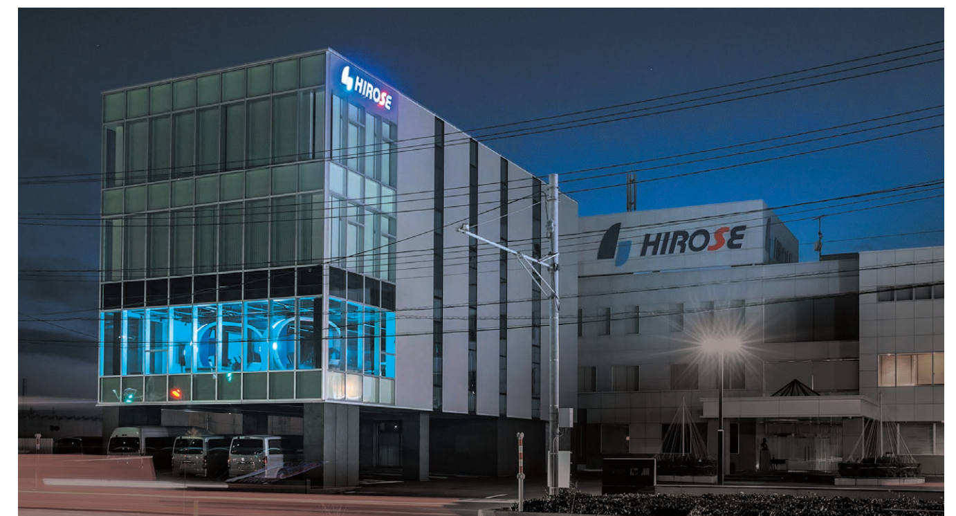
夜間、社屋に面した道路から見える遠隔操作コックピット
