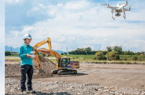
ドローンを活用した3D測量で正確かつ効率的な測量を実現
