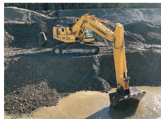
濁った水中ではバケットが目視できず、ICT建機がその真価を発揮する
