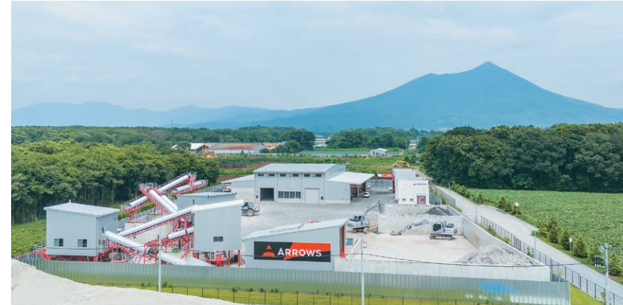
建築廃材と太陽光パネルを再資源化するアロウズエコプラント
