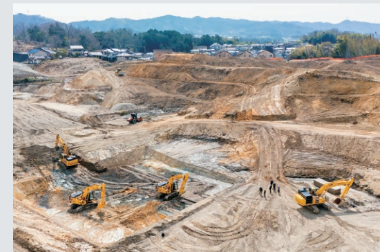
山林を宅地へと造成する工事現場。伐採はグループ会社のフォレスト総建、木くずのリサイクルは同じく伊賀林業が担当
