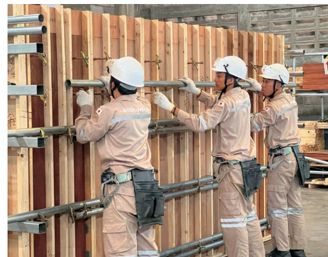
専門工事団体による技能訓練の様子 提供:JAC
