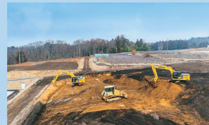
約4.5haにおよぶ圃場整備の工事現場。搬出予定の土量は13,000㎡にのぼる
