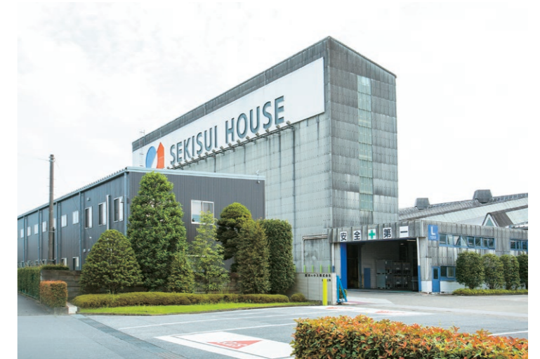
積水ハウスの基幹工場となる関東工場
