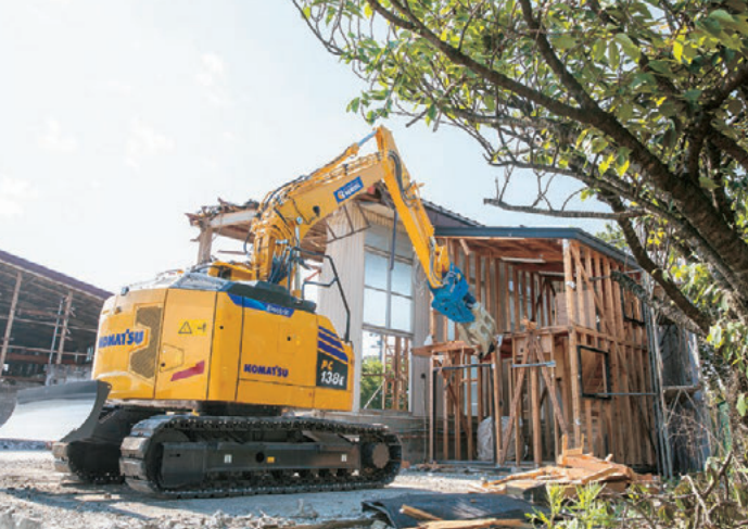
セミショートテイル仕様で小回りが利き、狭い現場でも作業が行える
