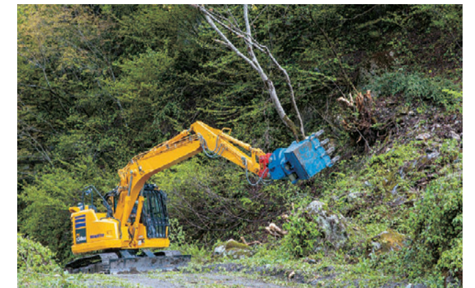
フェラーバンチャーで斜面の立木の伐倒作業を行うPC138US-11
