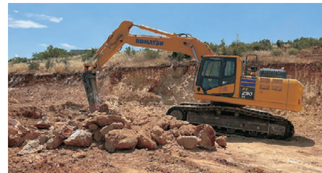
被災者用住宅の準備工事を行うPC290LC
