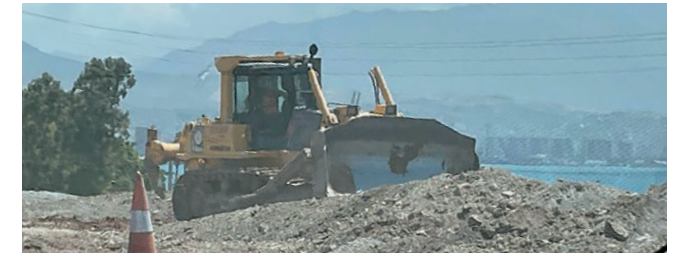
震災で壊れた道路の修復に当たるD85EX
