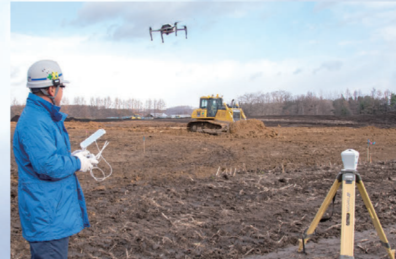
建設現場全体の地形の変化などをドローンで確認。ドローンから得られた情報はコンピュータを搭載したEdge Boxに送られ不要除去まで高速処理。その場で点群データを確認できる
