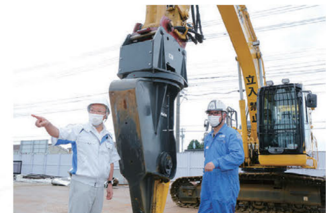
この建機を導入したことで、劇的に工数削減することができたという。写真は、石原専務(左)と、オペレーターの土肥氏(右)
