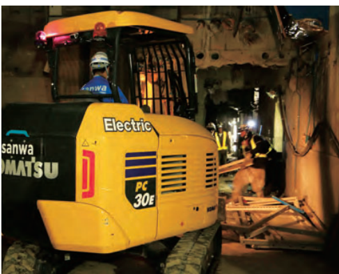
狭所の地下解体でもスムーズに作業
