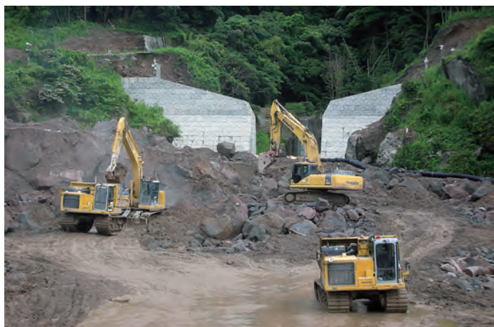
ブレーカーによる破碎・掘削・積込・運搬作業
