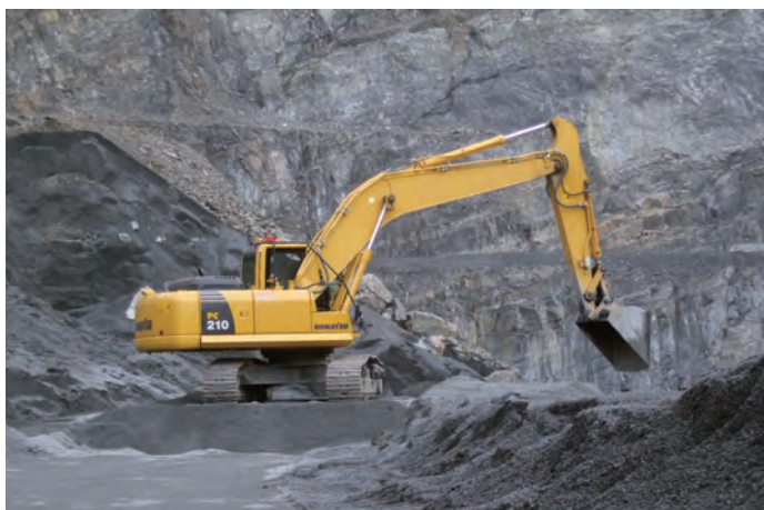
落石処理作業
