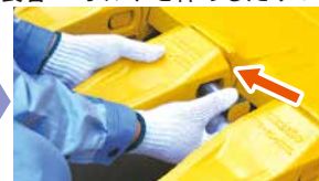
② ピン穴に専用ピンを挿入
