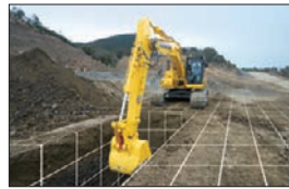
ICT 建機の刃先データ
