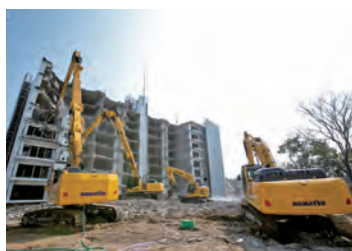
解体仕様油圧ショベル
