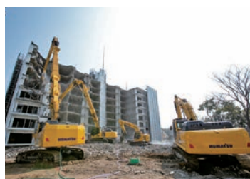
解体仕様油圧ショベル
